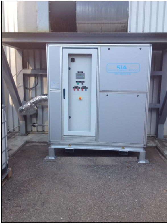
Figura 1- Installazione UTA
